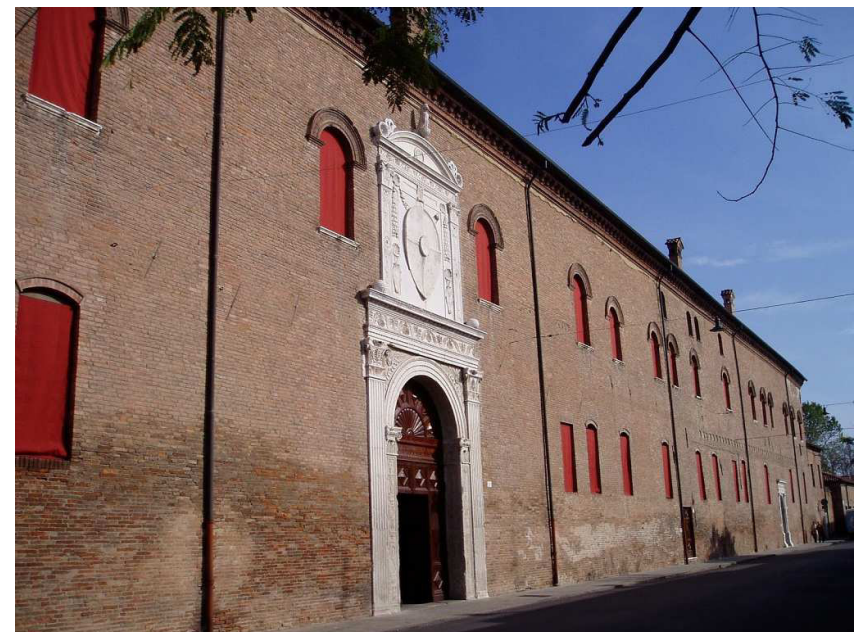
Facciata di Palazzo Schifanoia
