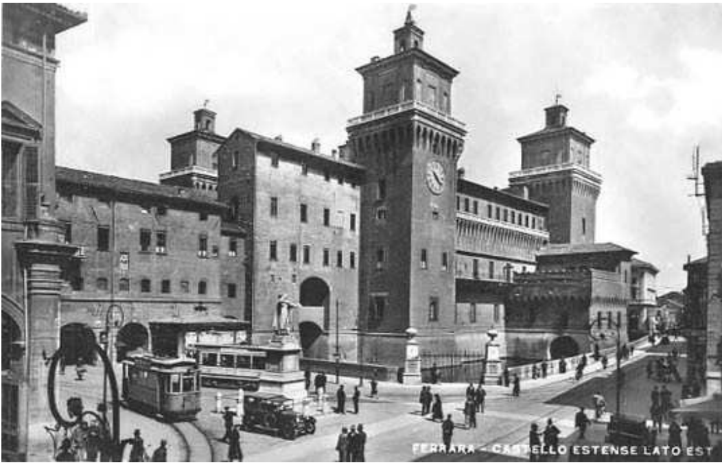
Castello Estense o Castello di San Michele commissionato all'architetto Bartolino da Novara da Niccolò II d'Este, 1385.
