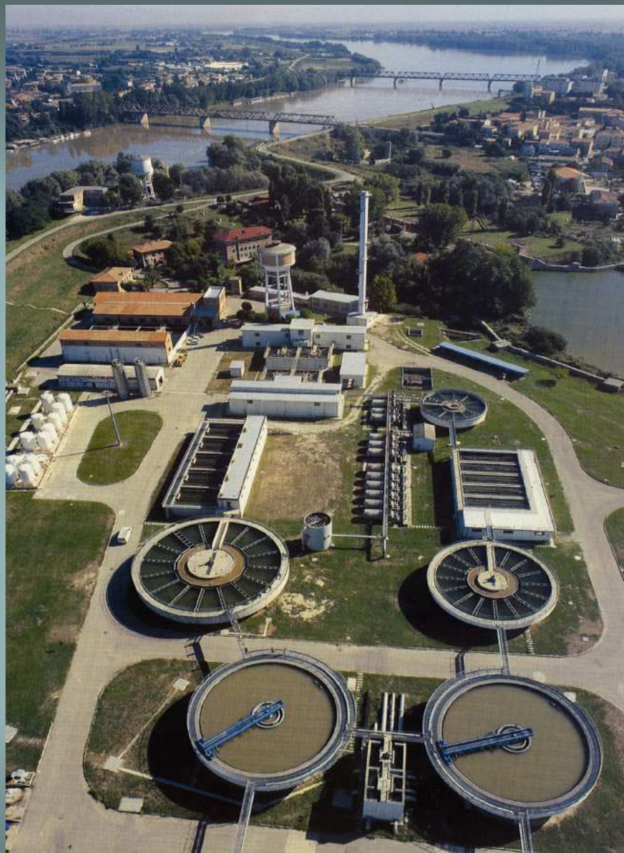
La centrale di potabilizzazione di Pontelagoscuro ai limiti del corso del fiume Po
