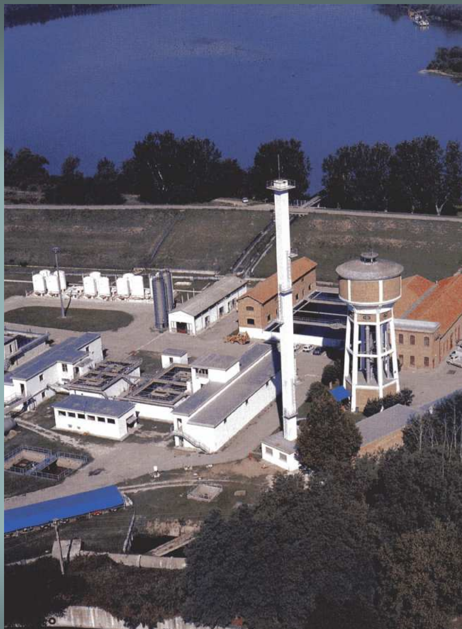
La centrale a ridozzo dell'argine del Po
