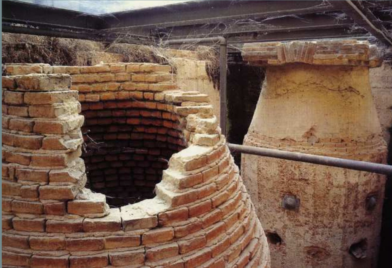
Serbatoi del pozzo cisternato di palazzo Paradiso
